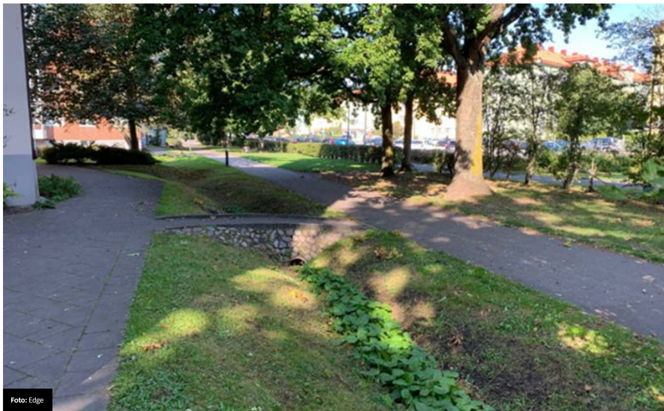
Figur: En principskiss över ett svackdike (stockholm-vattenochavfall.se).
