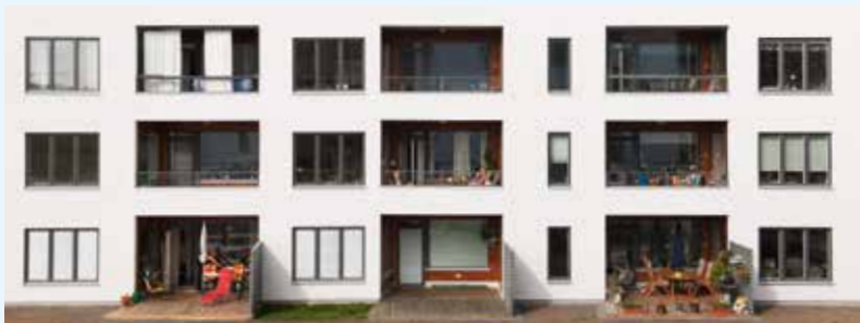
Putsad vit fasad, Moelven. Träbyggnader är ibland inte vad de ser ut att vara. Det finns gott om träbyggnadsprojekt med massiv trästomme och putsad fasad. Foto: Andreas Hylthén
