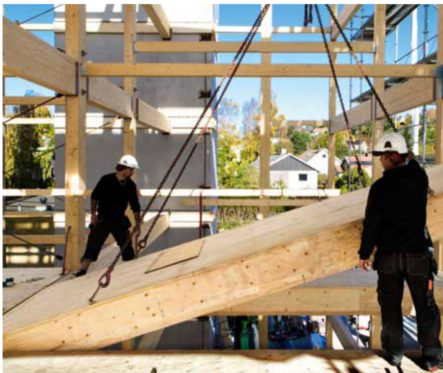
Industriellt byggande, Moelven. Förtillverkning och en industriell process innebär avsevärt kortare byggtider än traditionellt byggande. Foto: Sören Håkanlind.
